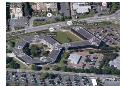
Restructuration du campus Mérignac TRC/DO
