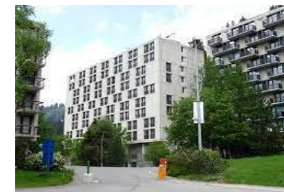
Rénovation de l'Hôtel Aujon Flaine à Chamonix TRC/DO
