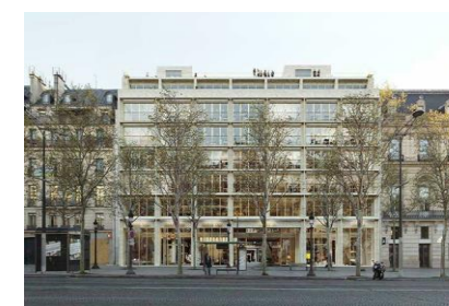
Rénovation lourde d'un ensemble immobilier sur les Champs Elysées TRC
